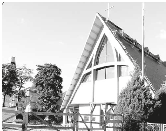
Budowa kaplicy w Kobylanach.
