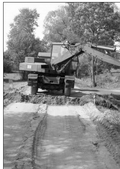
Budowa drogi gminnej w Podedwórze
