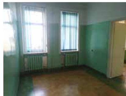
Sala chorych przed remontem
